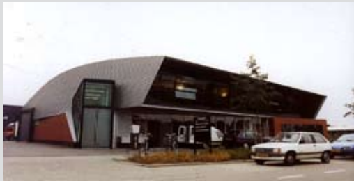
Laden / lossen aan de zijkant
