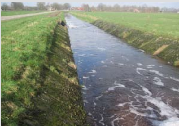
Bestaande centrale watergang
