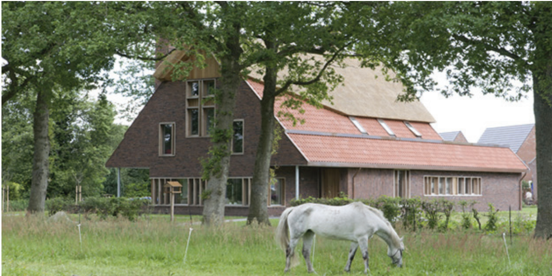
bestaande hoeve als kloeke verschijning
